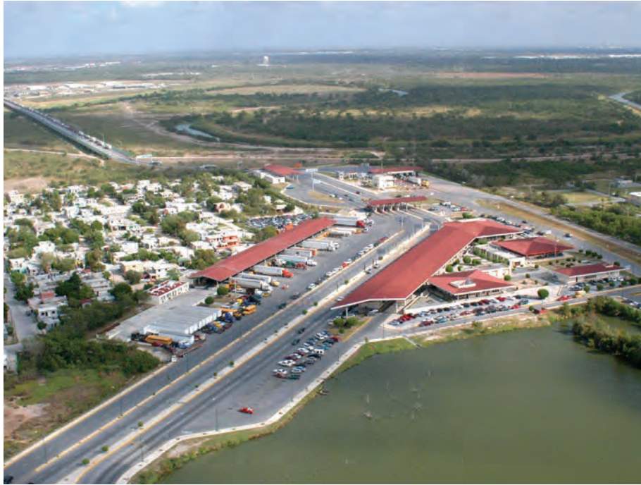
Puente General Ignacio Zaragoza–Los Tomates, que es parte de la múltiple infraestructura de comunicaciones modernas con las que cuenta Matamoros. [Gobierno del Estado de Tamaulipas]
