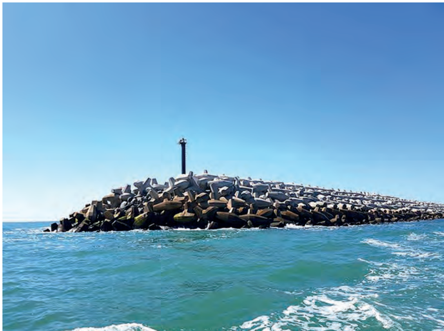
Remate de una de las escolleras, construida a base de rocas y de enormes dados tri-podes de concreto, para soportar el embate de las mareas. [Jesús González Echazarreta]
