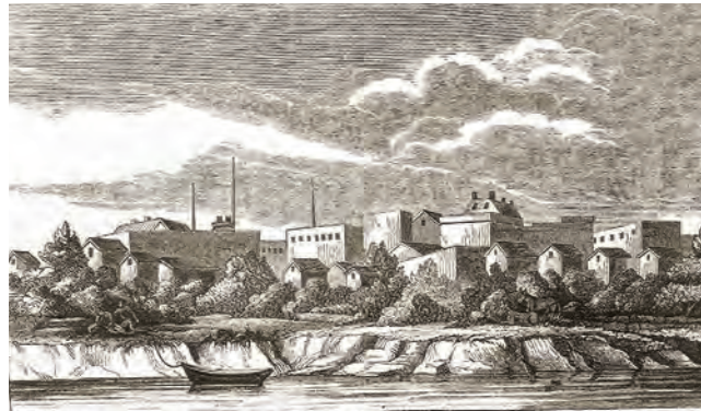
Matamoros en 1846, tras el ciclón que azotó dos años atrás y derribó las torres de la iglesia, pero dejó intactos sus sólidos edificios de ladrillo. [Jenkins Garrett Library]
