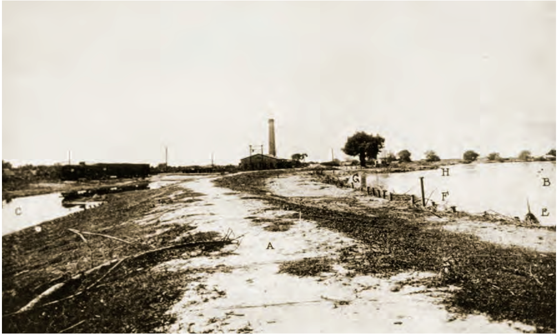
Primer bordo de defensa del río Bravo, construido a inicios de la década de 1920, para tratar de impedir la inundación de la ciudad de Matamoros. Al fondo la planta eléctrica, donde estuvo el fuerte Paredes. [Secretaría de Relaciones Exteriores]
