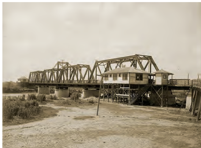
Puente ferroviario internacional, concluido en 1911, cuya estructura podía hacer girar sus segmentos, para permitir la navegación fluvial. [Museo de los Ferrocarriles Mexicanos, Puebla]
