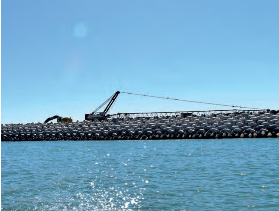
Escollera sur del puerto de Matamoros, casi al final de su terminación completa, lo que permitirá asegurar un canal de navegación apto para el puerto. [Jesús González Echazarreta]
